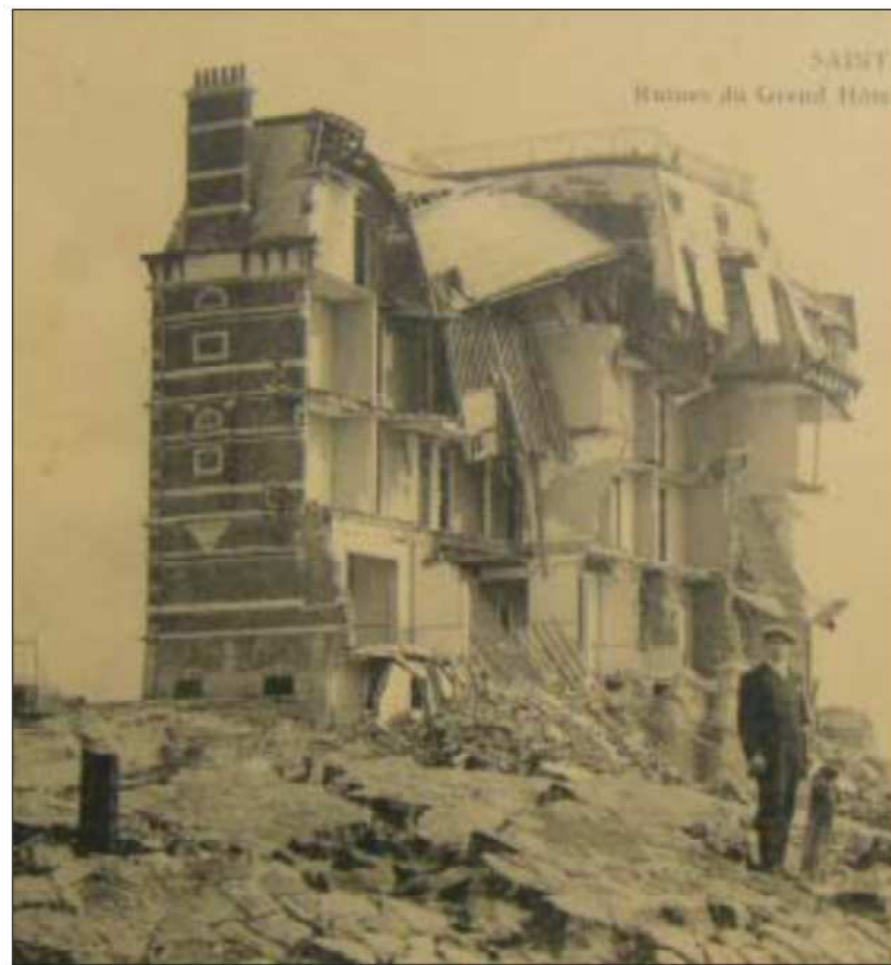
Si la tempête a laissé intacte la façade arrière de l'hôtel, on ne peut en dire autant de sa façade regardant la mer...
